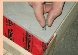
4 Trou plus grand que le diamètre de la vis
